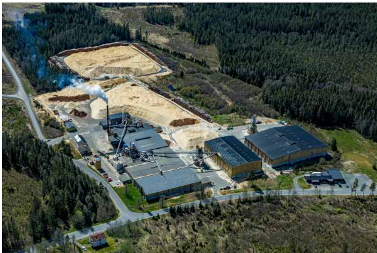
Brand i silo utanför Malmbäck. Februari 2023.
