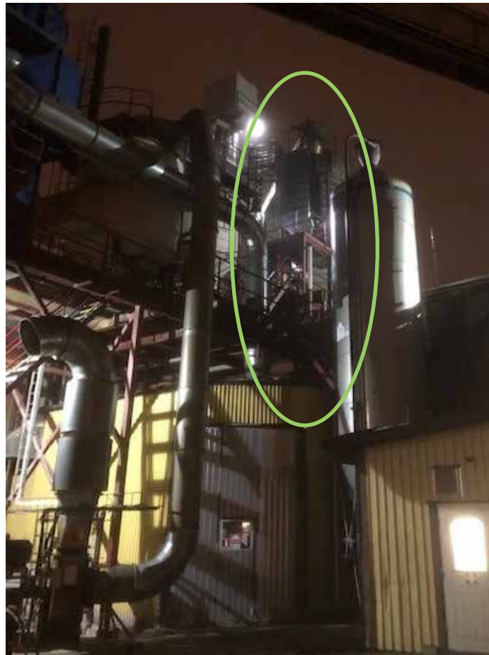
Drabbad silo var omsluten av fabriksbyggnaden.
