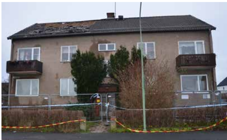
Byggnaden med två vanliga bostadsvåningar, en våning med inredd vind och en oinredd låg "tredje vind".
