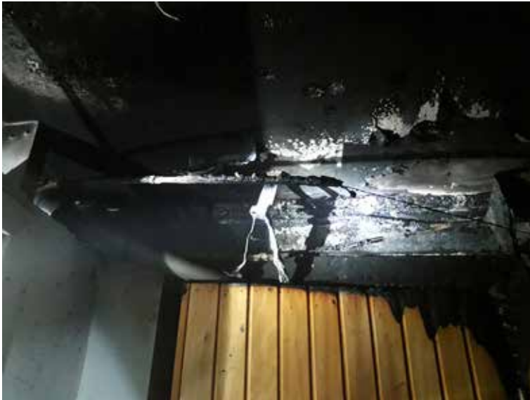
Bilden är tagen utanför bastun och det går att se det rör som brunnit av och vid detta ögonblick hänger in bakom bastudörren.
