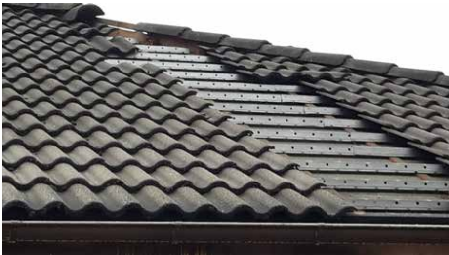
Takläkt av plåtreglar
