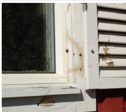
Angrepp med skärsläckaren utifrån. Kvar syns bara några små bål.
