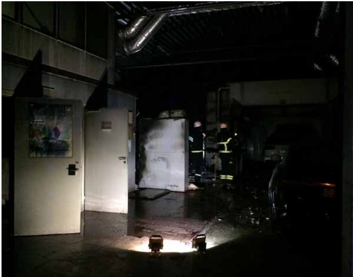
Mellersta delen av byggnaden. En lackbox skymtar i bakgrunden till höger och ett tydligt brand-v syns i mitten. Ovanför dörrarna syns entresolplanet.
