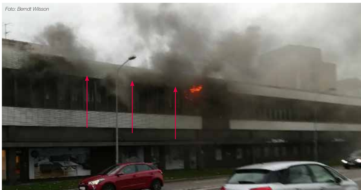
Branden spred sig vidare ut genom konstruktionen till "lådan" ovanför fönstren.
